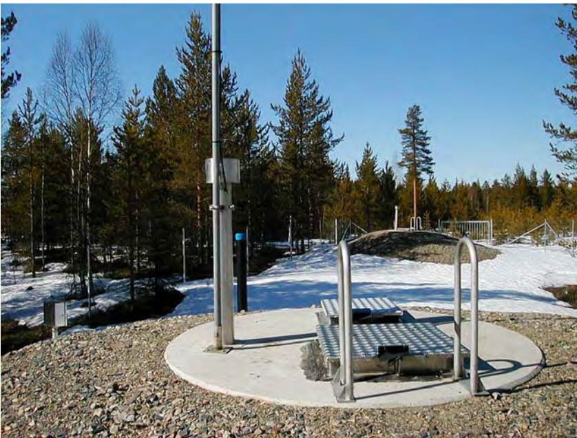
Kemin ja Tornion kaupungeille juomaveden toimittavalla Meri-Lapin Vesi Oy:llä on yli kymmenen vuoden kokemus kaiken vesihuollossa tarvittavan tekniikan omatoimisesta rakentamisesta ja ylläpidosta. Meri-Lapin Vesi Oy on ensimmäinen vesilaitos, missä vedenottamon koko automaatio rakennetaan taajuusmuuttajaan.
