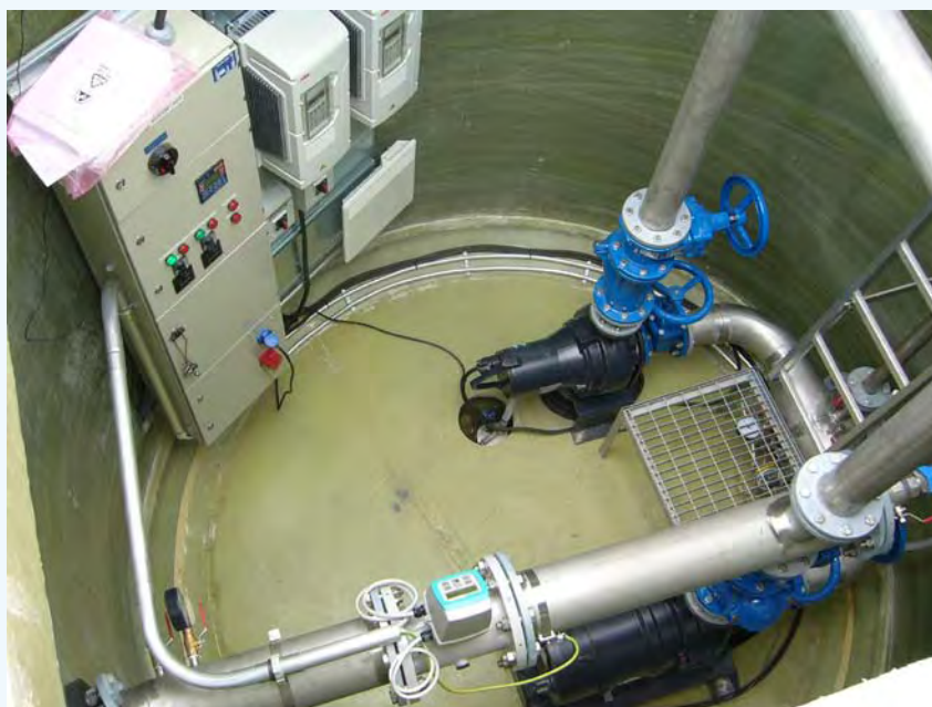
Matalaenergiapumppaamo on suljetun kierron ansiosta sisältä siisti ja miellyttävämpi huoltaa.
