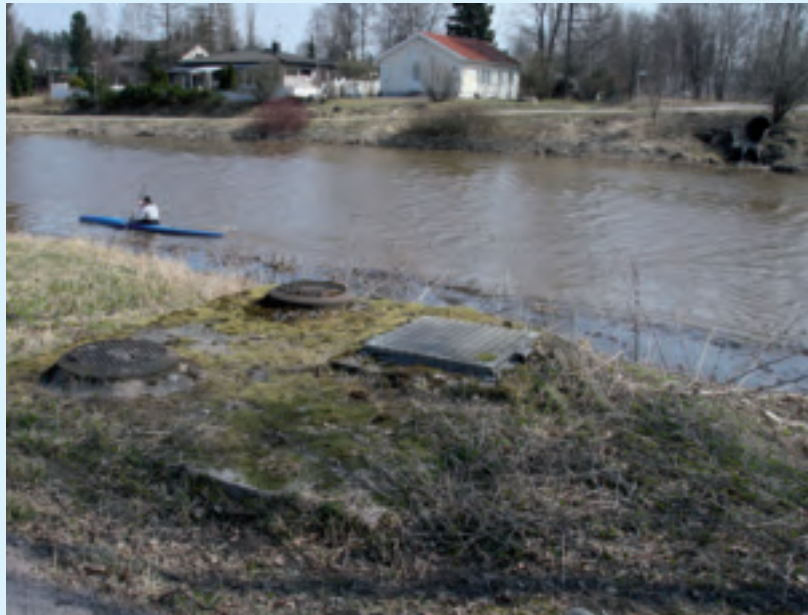
Kuntotarkastus huomioi myös pumppaamon ympäristön. Eräs tarkastettava asia on, jääkö sähkökeskus veden alle joen mahdollisesti tulviessa.
