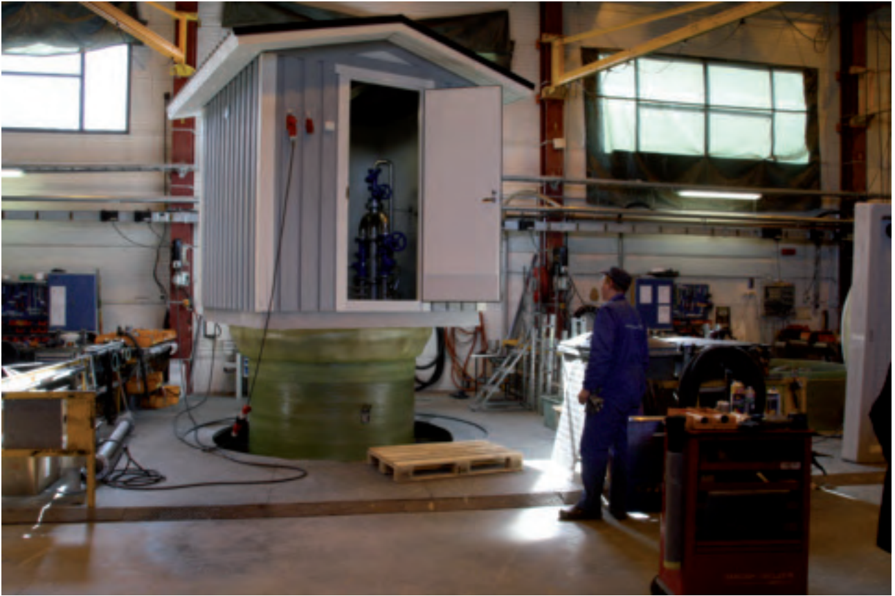
Modernin jätevesipumppaamon valmistusta Joutsassa. Maahan kaivettava, kelaamalla tehty lasikuitukaivo kerää jätevedet. Taloudelliset uppopumput siirtävät veden viemäriin. Huolto- ja valvontatyöt tehdään turvallisesti ja mukavasti kaivon päälle sijoitetussa pienessä mökissä.
