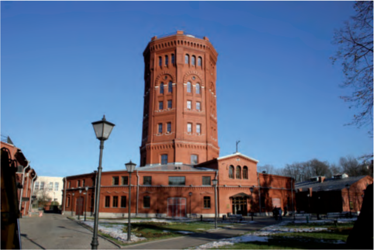
Pietarin vesimaailma sijaitsee lähes 150-vuotiaassa vesitornissa.
