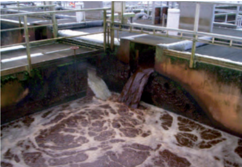
Kuva 4. Palautuslietteen pumppaus, sisäiset kierrätykset ja ilmastus ovat tärkeitä ohjauksia typenpoistossa.
