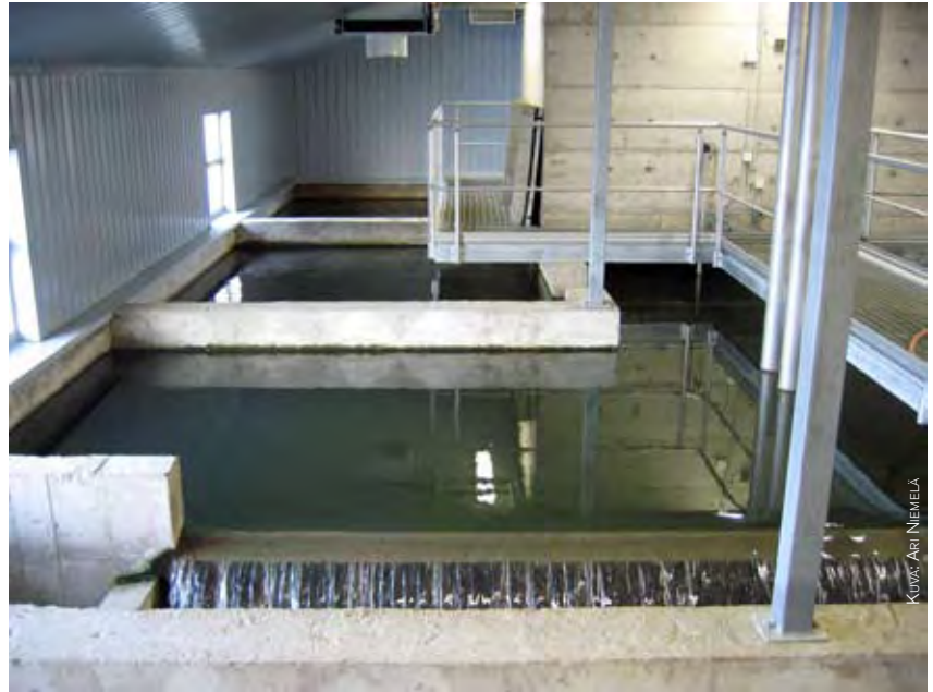
Parainen, Norrbyn jätevedenpuhdistamo, denitrifikaatiosuodatin.
