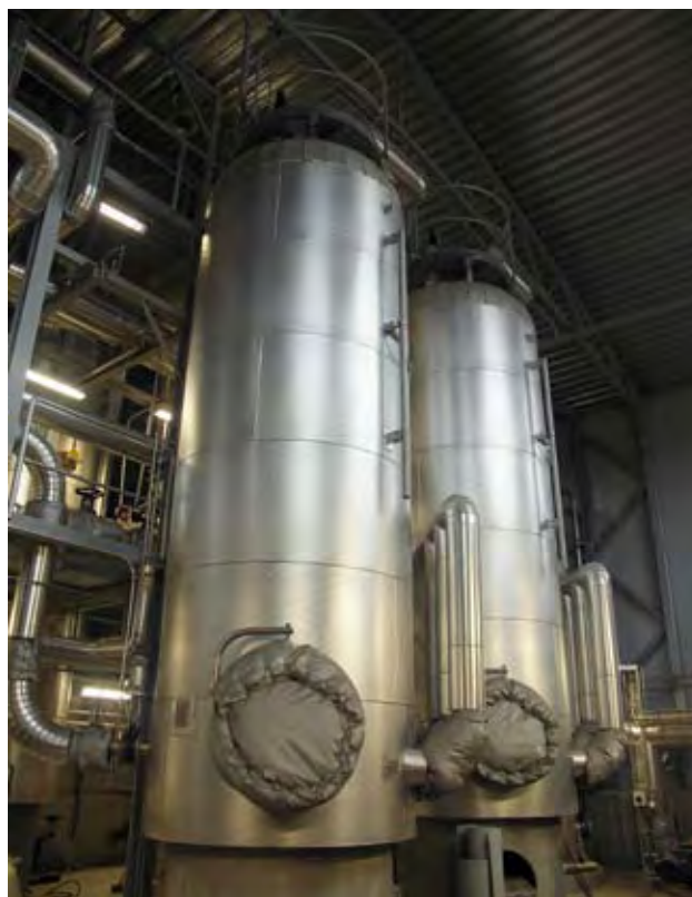
Kuva 1. Strippauskolonneissa ammoniakki erotetaan rejektivedestä.
