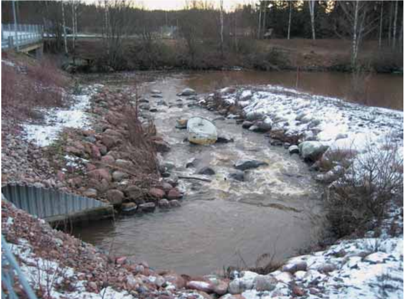
Kuva 1. Mustijoki-Mäntsälänjoen alimman padon kiertävä Brasaksen luonnonmukainen kalatie Porvoossa. Kalatie toimii hyvin (ks. Vesitalous 5/2003).
