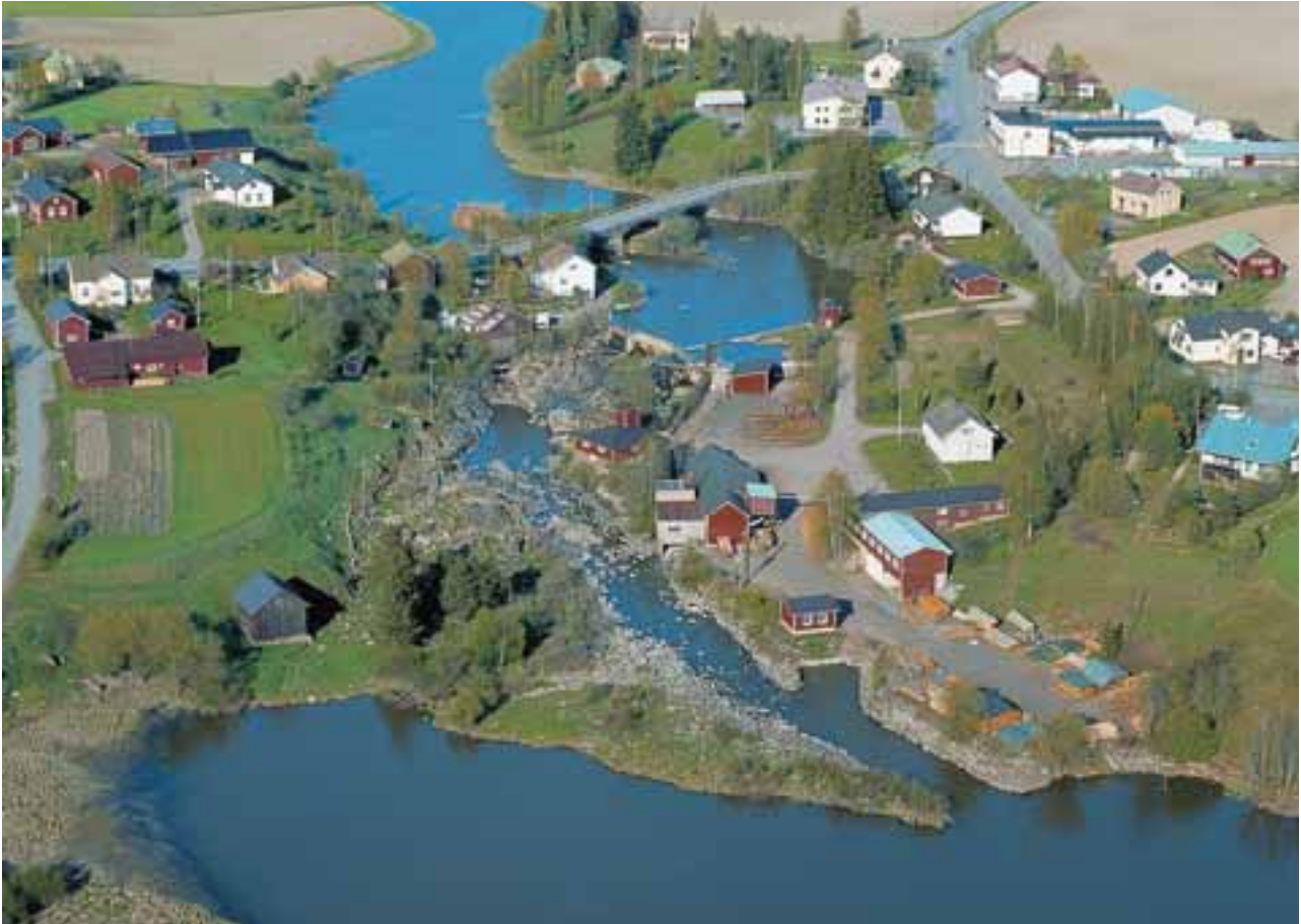
Kuva 2. Porvoonjoen Vakkolankoskessa on hiljattain saneerattu 0,5 MW minivesivoimala. Vesi ohjataan kosken yläpuolisesta suvannosta kosken itärantaa pitkin kulkevaa putkea pitkin kosken alaosassa sijaitsevaan minivesivoimalaan siten, että itse koskiuoma on suuren osan vuodesta kuivana. Koskeen on suunniteltu valtion varoilla kalatie, jonka rakentamisen kustannusarvio on noin 230 000 €.
