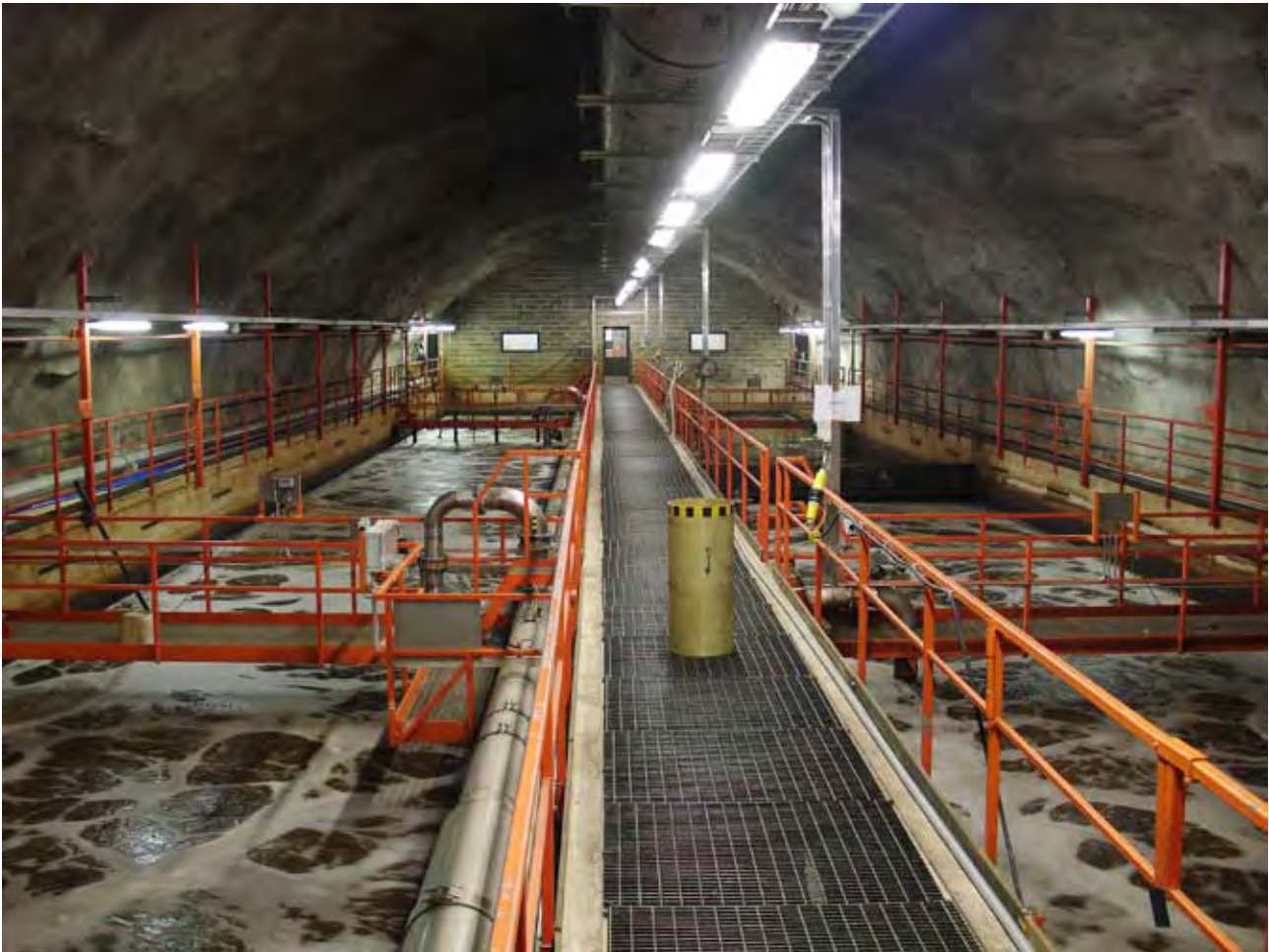
Kuva 3. Kalliopuhdistamo Lahden Kariniemessä (Kuva: Lahti Vesi).
