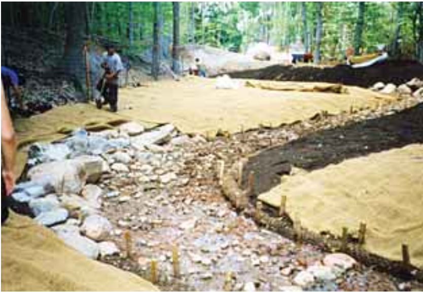
Kuva 4. Joessa, jossa tulvat ovat flash flood -tyyppiä, tarvitaan mittavia eroosiosuojauksia. Kunnostuksen kohteena Lemon Creek -puro Staten Islandilla, New York Cityssä. (kuva Terhi Helmiö)
