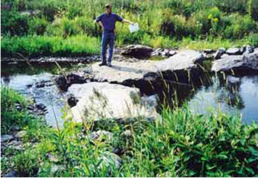
Kuva 3. Pienet joet saattavat tarvita suuriakin rakenteita kiviaineksen pysäyttämiseksi. Uudenmaan ympäristökeskuksen Kari Rantakokko seisoo v-suisteella Batavia Kill -joessa, New Yorkin osavaltiossa. (kuva Terhi Helmiö)
