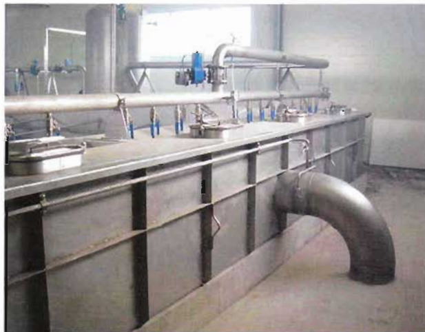
Kuva 8. Flotaation tulopää ja dispersioveden jako.
