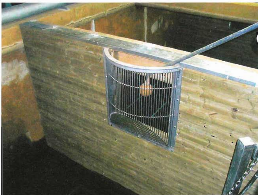
Kuva 4. Väliseinämä ja siivilä asennusvaiheessa.
