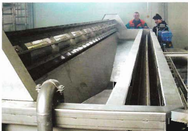
Kuva 9. Flotaatio asennusvaiheessa – lietteenpoisto-osa ja lähtevän veden tarkkailu.
