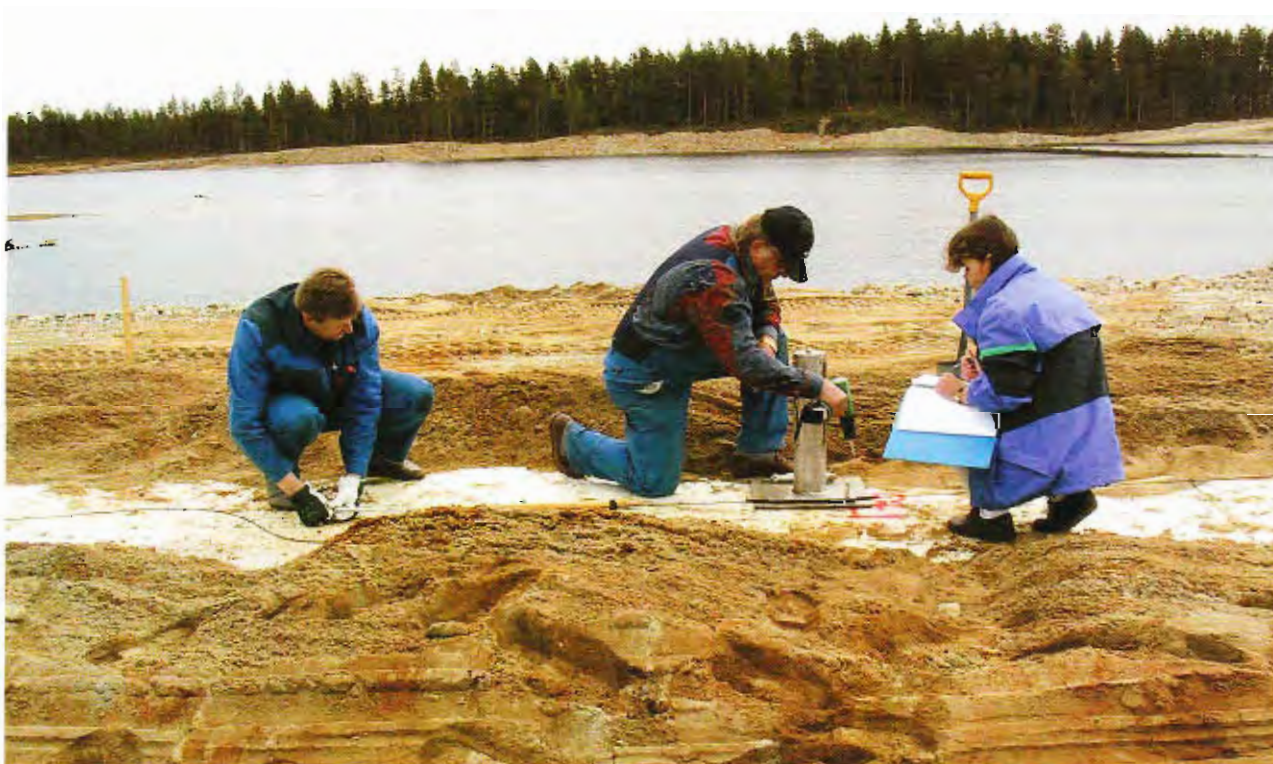
Kuva 5. Valokaapelin asentaminen vesivoimalaitoksen maapadon painuman valvontaan. (Kuva: Kemijoki Oy)
