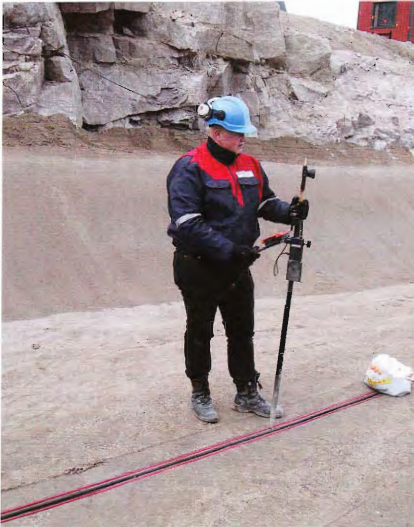
Kuva 7. Valokaapelin asentaminen kaatopaikan pohjarakenteen valvontaan. (Kuva: Ekokem Palvelu Oy)
