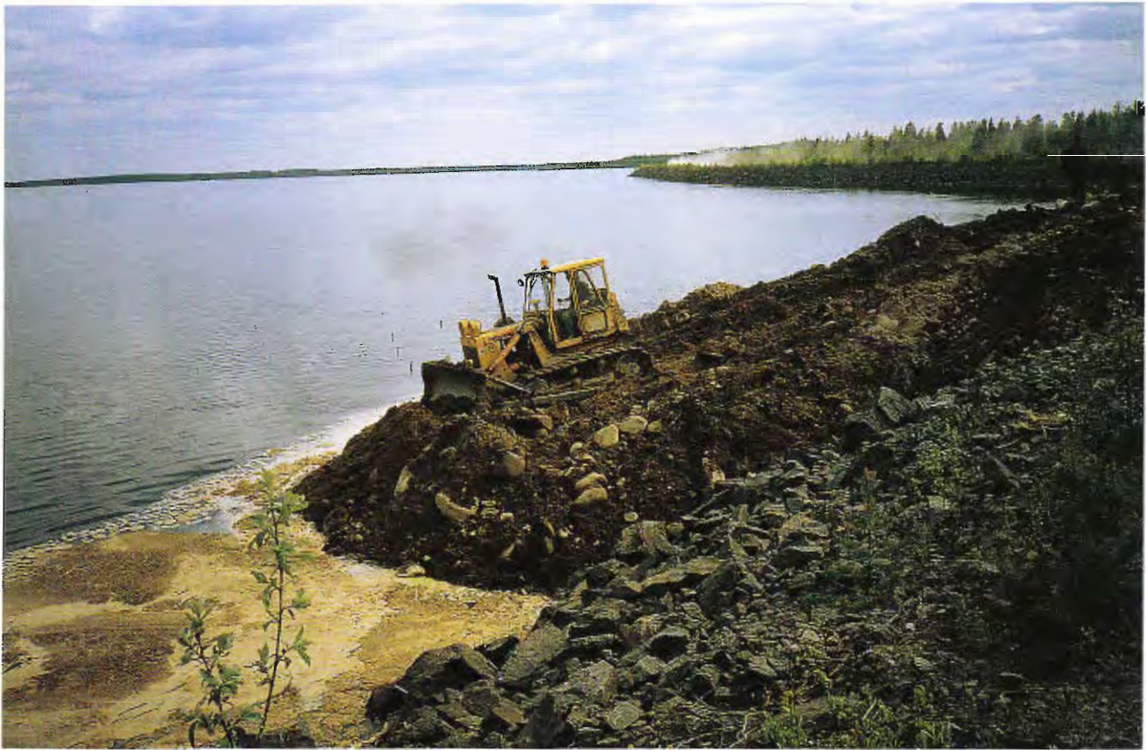
Kuva 3. Uljuan patovuodon röstäytyminen estettiin toukokuussa 1990 nopein korjaustoimenpitein.
