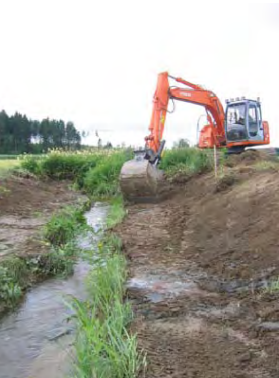
Kuva 1. Tulvatasanteen kaivua Perniön Juottimenojalla, jossa esiintyy meritaivementa. Tulvatasanteet kaivetaan erikseen uoman molemmilta puolilta tai leveämpänä vain toiselle puolelle. Kuva Liisa Laitinen.
