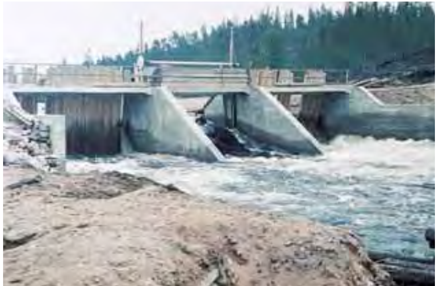
Betonista rakennettu uittopato.
