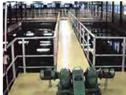
Tasaukseen käytettävät esiselkeytysaltaat. (Kuva J. Rautiainen)
