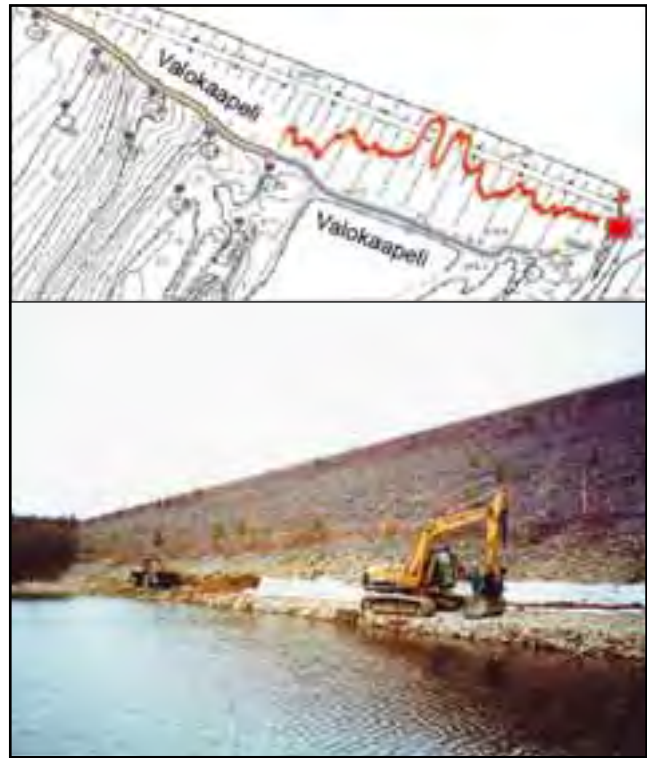
Kuva 1. Vesivoimalaitoksen padon valvontaan asennettu 4 km pitkä valokaapeli seuraa suotoveden vaihteluita.
