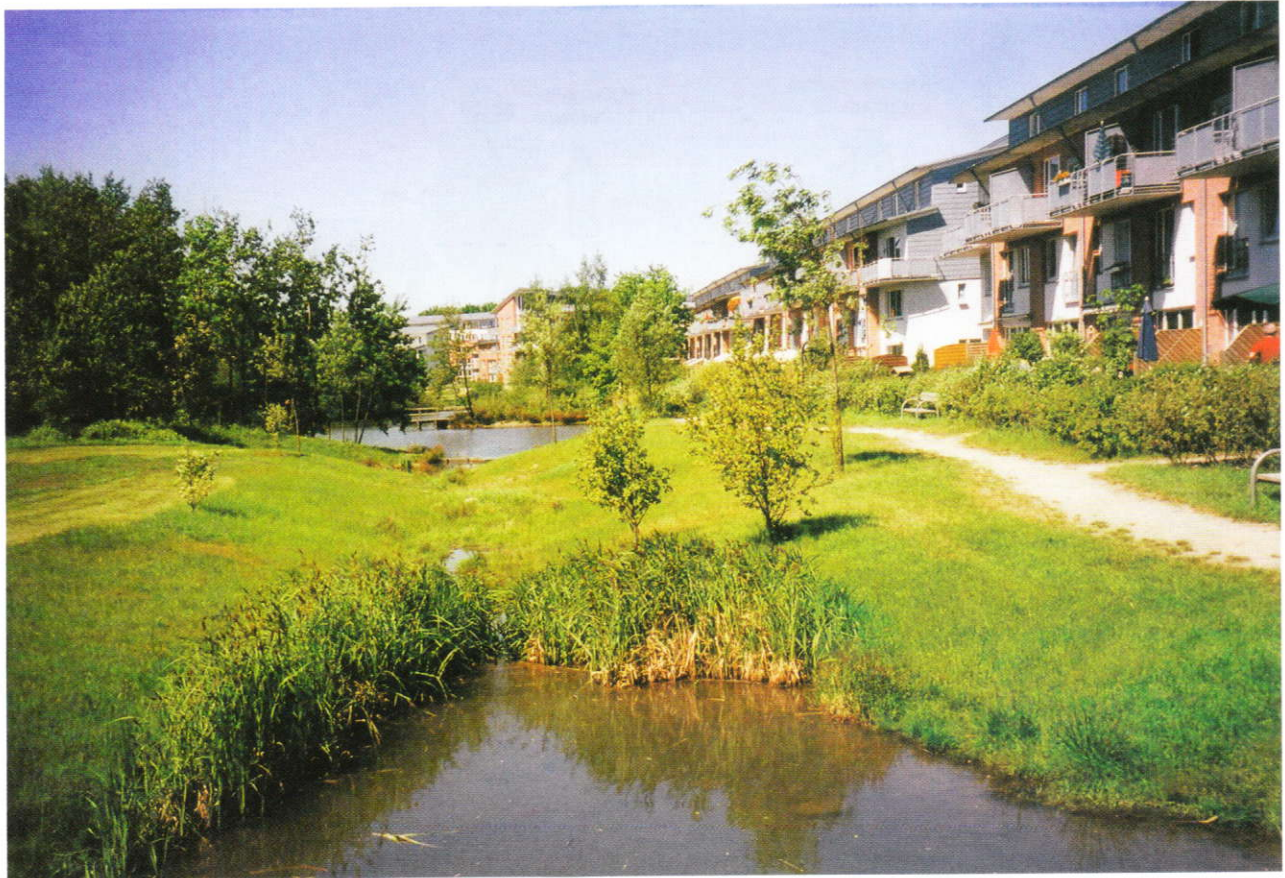
Kuva 2. Asuinalueen keskelle toteutetut kosteikot ja lammikot auttavat mm. kaupunkitulvien hallinnassa. (Kuva: Vaasan kaupunki/Kunnallistekniikka; Vital Vaasa, EU-hanke)
