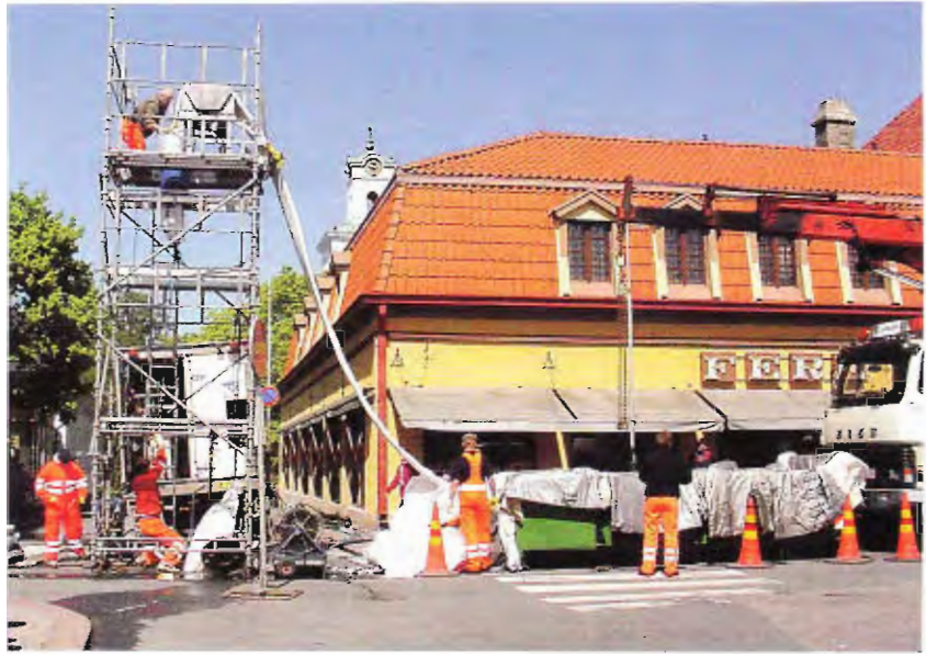
Kadulle pystytetty torni, jonka kautta sukkaa sujutetaan.
