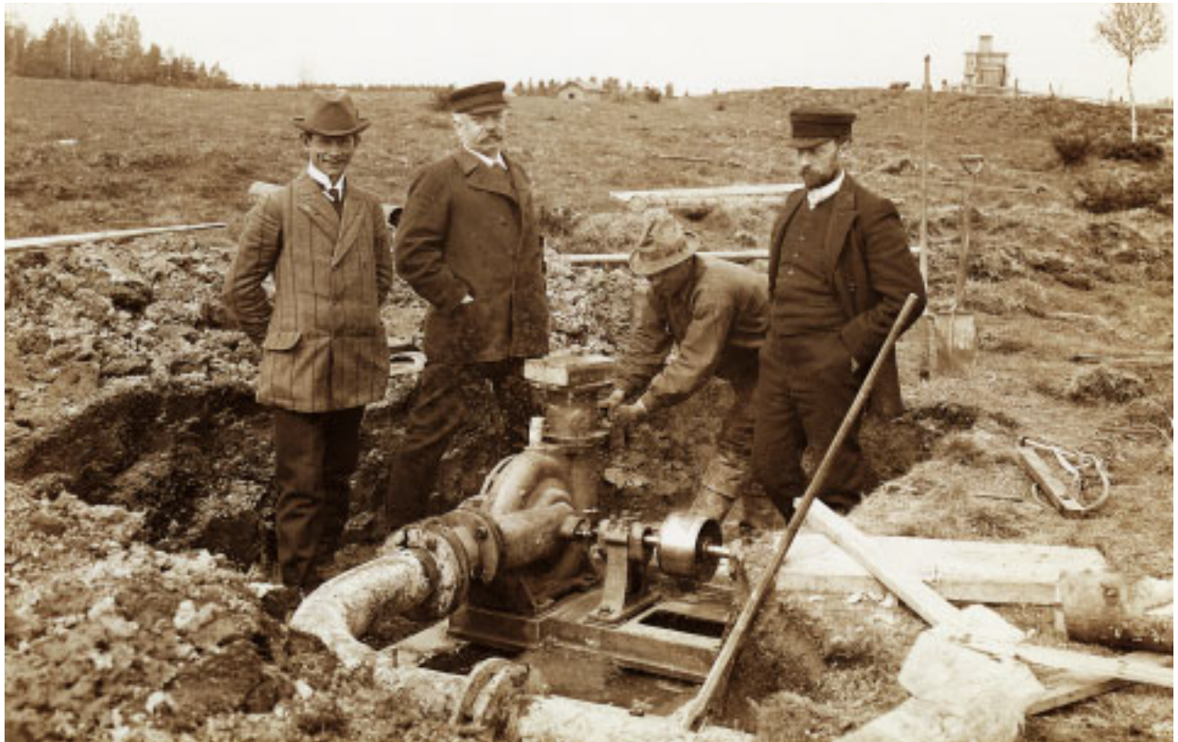
Kuva 1. Pohjavesien koepumppauksia Vaasassa 1910-luvun alussa (Kuva: Pohjanmaan museo)
