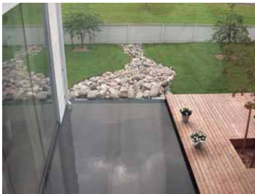
Kuva 2. Yksityistontin kattosadevedet kootaan matalaan altaaseen, josta ne johdetaan edelleen viheralueille.
