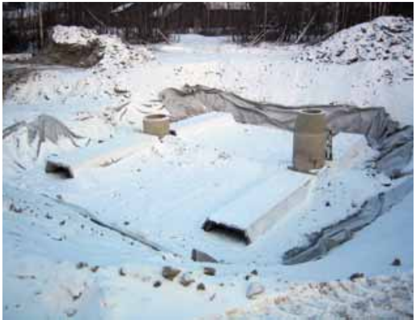
Kuva 8. Pitkänmöljätien hulevesien laskeutusallas rakenteilla.
