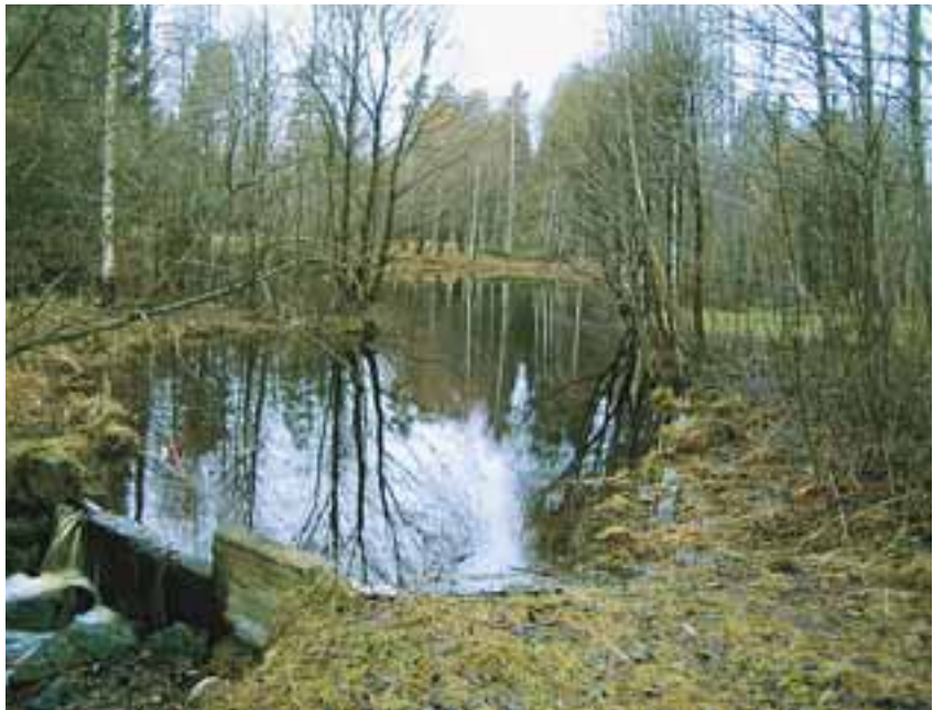
Kuva 3. Gerbyn lammikot ja ylisyöksypato
