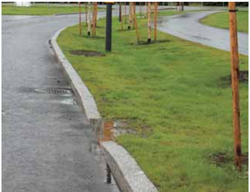
Kuva 9. Pitkänmöljätientielle johdetaan viherkaistalle katupintavesiä.
