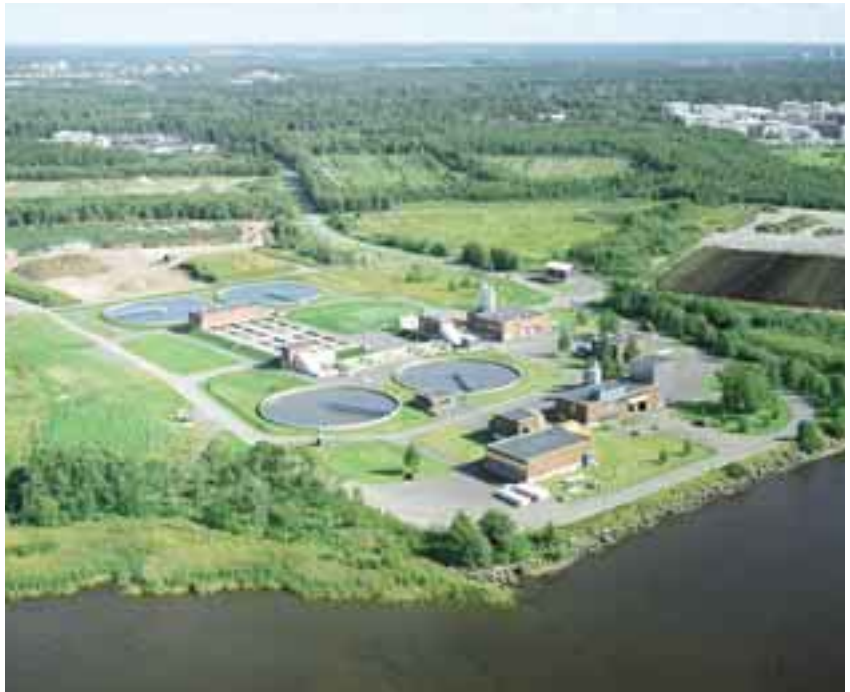
Kuva 4. Ilmakuva Oulun Veden Taskilan jätevedenpuhdistamosta; laajennus, joka käsitti aktiivilietelaitoksen ilmastusaltaan ja yläosassa näkyvät pyöreät jälkiselkeytsaltaat, otettiin käyttöön vuoden 2005 alussa, minkä jälkeen puhdistustulokset ovat olleet hyviä. (Kuva: Oulun Veden arkisto)
