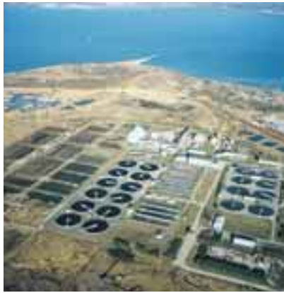
Kuva 1. Paljassaaren jäteveden puhdistamo. (Kuva: AS Tallinna Vesi)
