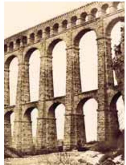
Kuva 2. Antiikin ajan akvedukti Roquefavourissa, Ranskassa. Valokuva Édouard Baldus, noin 1850. (Lähde: Turo Manninen, Ei vettä rantaa rakkaampaa OULUN VESILAITOS VUOSINA 1902–2002, Oulun Vesi 2002. )
