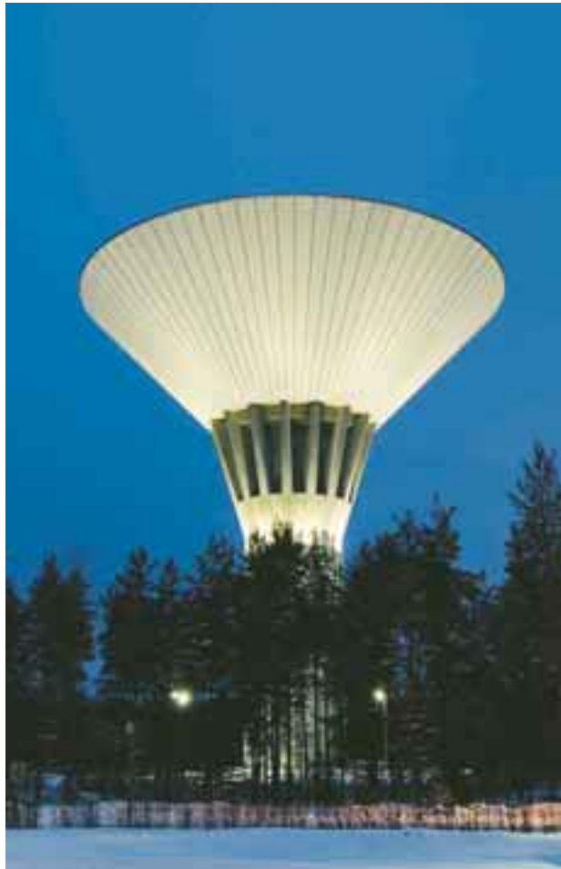
Kuva 3. Oulun Veden Maikkulan vesitorni valmistui Knuutilankankaalle v. 1993. Vesitorni on tasamaastoisessa Oulussa korkeatasoisen vesihuollon yötä päivää näkyvä symboli. (Kuva: Juha Sarkkinen)
