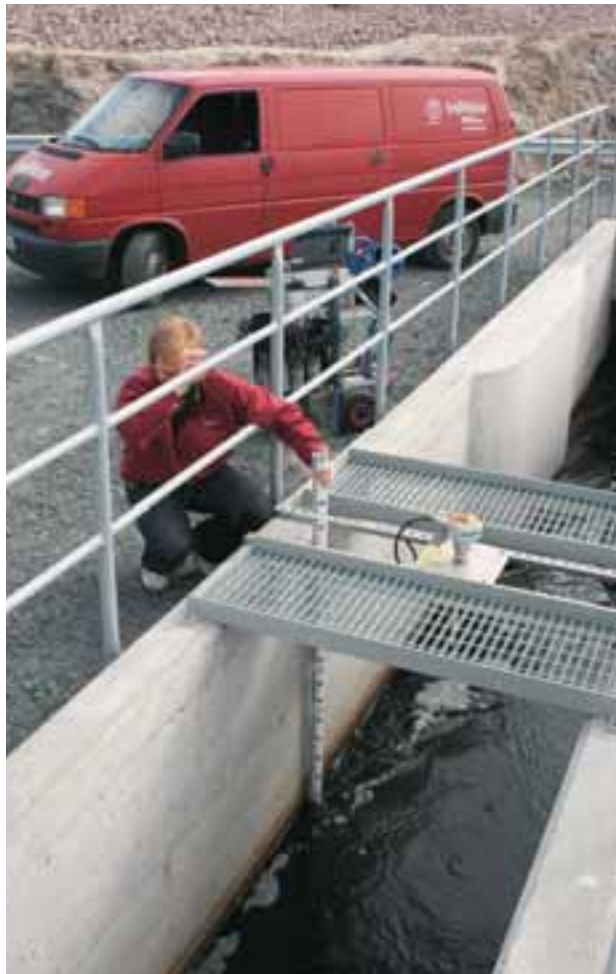
Kuva 1. Jäteveden virtausmittauksista suuri osa on avokanavamittauksia. Ne on rakennettu usein suosituksista poikkeavasti, jolloin purkaukikäyrä ei ole sama kuin teoreettinen käyrä. Lisävaikeuksia mittauksen laadussapidolle aiheuttavat likaantuminen ja veden mukana kulkeva kiintoaine.
