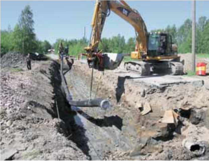
Kuva 4. Verkostojen saneeraustyömaan putkia ja kaivoja. Kuva Porin Vesi
