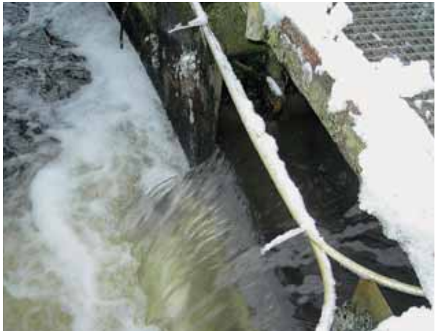
Kuva 1. Jäteveden virtausmittauksista suuri osa on avokanavamittauksia. Ne on rakennettu usein suosituksista poikkeavasti, jolloin purkaukikäyrä ei ole sama kuin teoreettinen käyrä. Lisävaikeuksia mittauksen laadussapidolle aiheuttavat likaantuminen ja veden mukana kulkeva kiintoaine.
