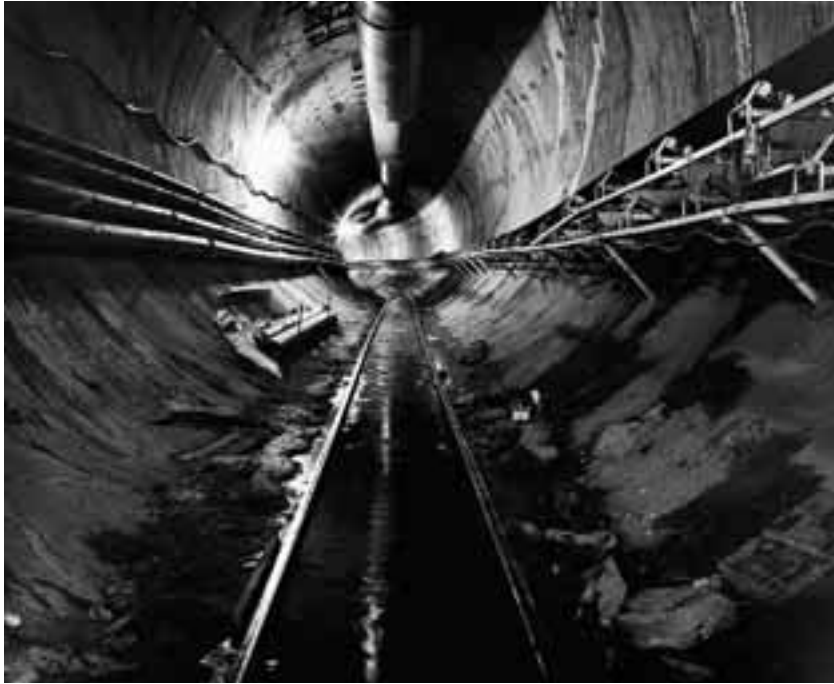
Kuva 4: City Tunnel No.3, Queens, New York, 1998
