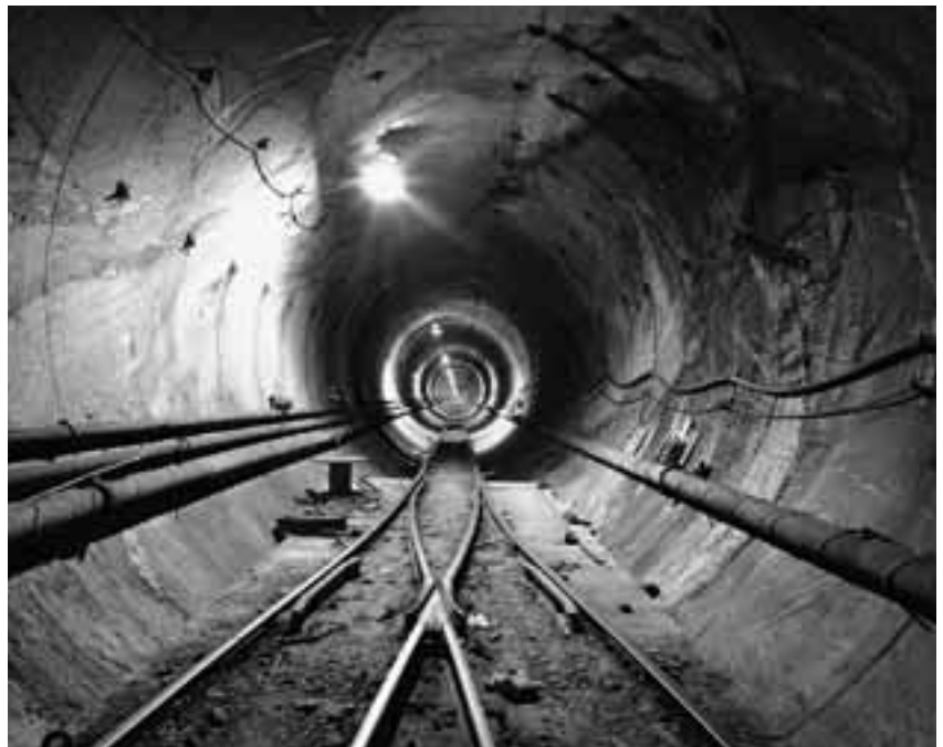
Kuva 5: City Tunnel No. 3, Queens, New York, 1998
