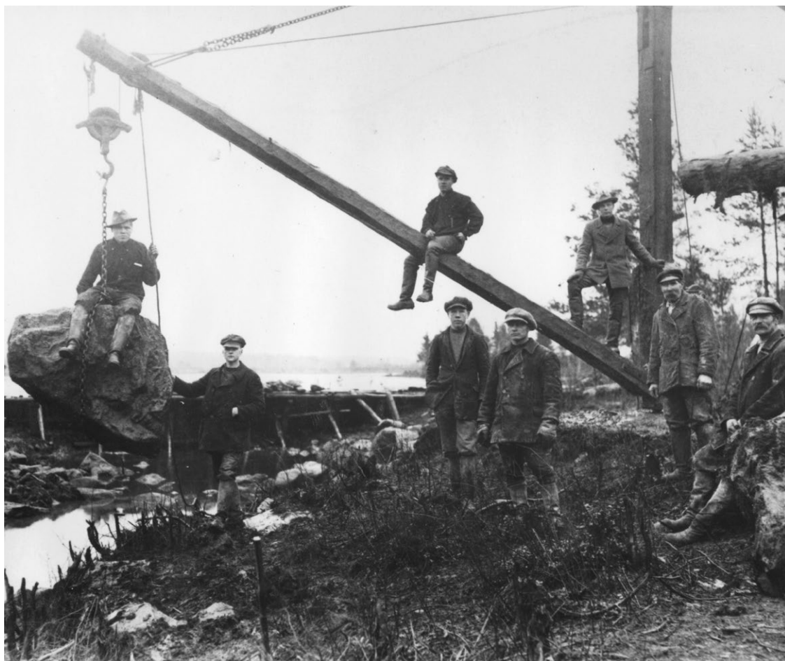
Suomessa laskettiin 1800- ja 1900-luvuilla yhteensä 3 000 järveä maatalousmaan lisäämiseksi. Uiton helpottamiseksi perattujen koskien määrästä on vain arvauksia. Kuvassa perataan koskea 1920-luvulla Tyrvään Illonjoella. Kuva: Lauri Piranen / Sastamalan seudun museo.
