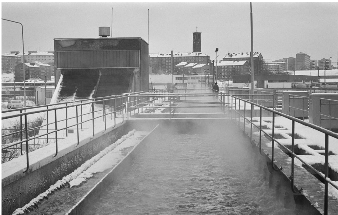
Vuonna 1932 rakennettu Kyläsaaren puhdistamo oli Pohjoismaiden ensimmäinen aktiivilietelaitos, jossa bakteerit ja alkueläimet hajottivat jätelietteestä orgaanista ainesta. Kyläsaaren jätevedenpuhdistamon ulkoaltaita vuonna 1975. Kuva: Eeva Rista / Museovirasto.
