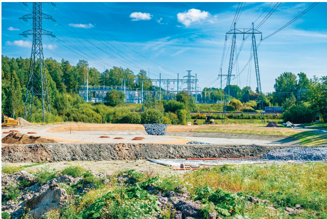
Kaupungit ovat 2010-luvulta lähtien kiinnittäneet entistä enemmän huomiota hulevesien hallintaan. Vantaan Haxberginhaan hulevesialtaiden rakennustyömaa Elmon urheilupuiston alueen itäpuolella 2024. Kuva: Eero Happonen / Vantaan kaupunginmuseo.
