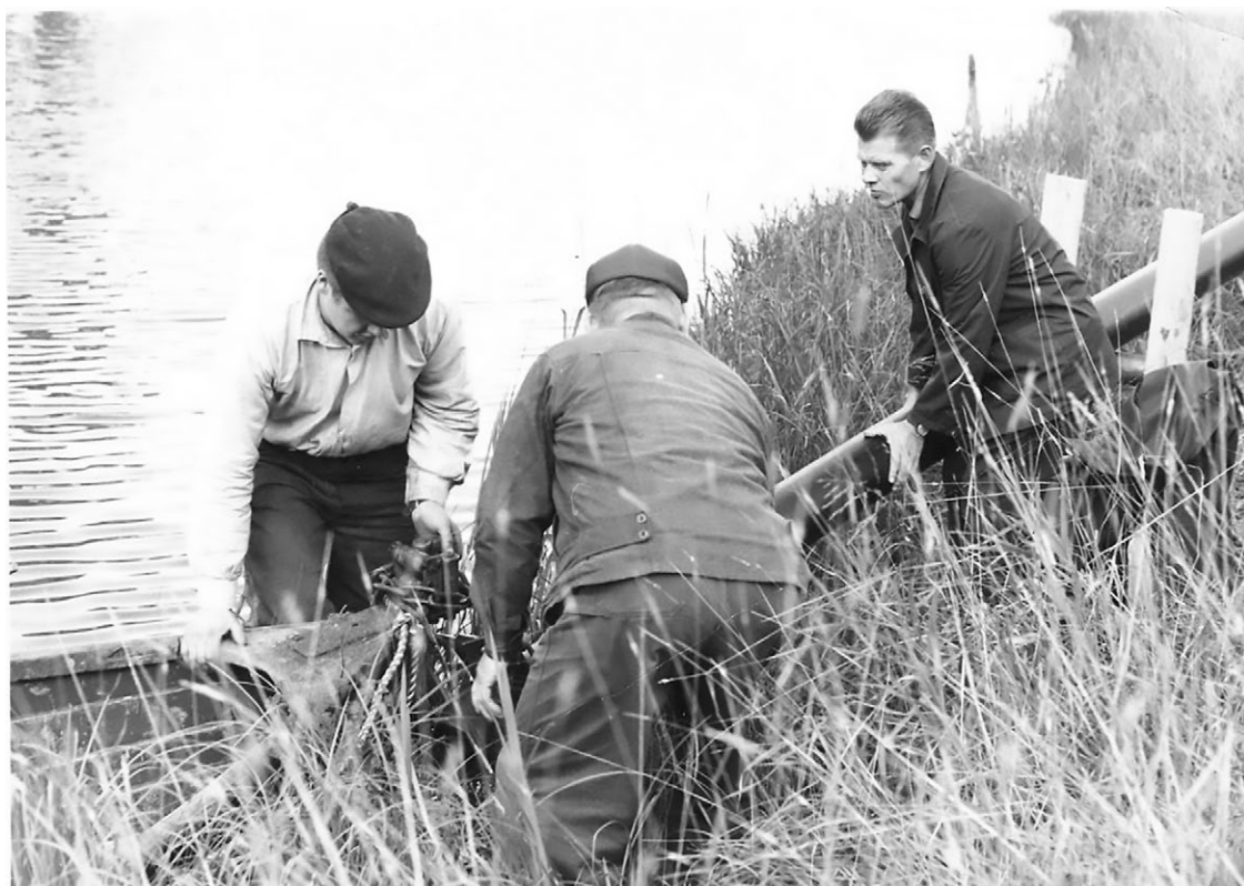
Maaseudun vesihuoltoon alettiin kiinnittää kasvavaa huomiota 1960-luvulta alkaen. Uudet muoviputket helpottivat vesihuoltoverkoston rakentamista. Muovista paine- viemäriputkistoa lasketaan mereen Espoossa 1967. Kuva: Forssan museo.
