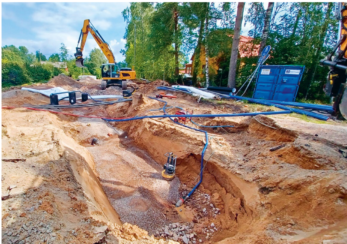
Suomen vesihuollon infrastruktuuri alkoi tulla saneerausikään 1990-luvulta lähtien, ja korjausvelka on sittemmin kasvanut. Haminan Savitien saneerauksen yhteydessä korjattiin myös tien alla kulkevat vesi- ja viemäriputket vuonna 2024. Kuva: Kari Kääriä / Haminan Vesi.
